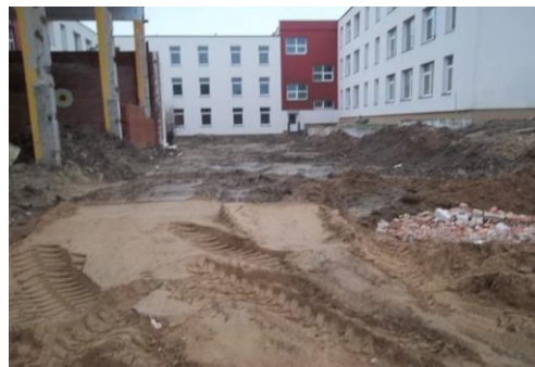
Zarasų sporto centro erdvių atnaujinimo darbai
